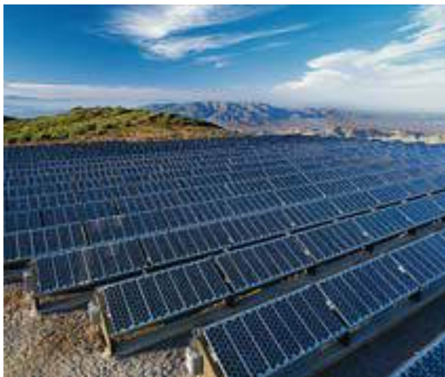
Paneles solares. GETTY
